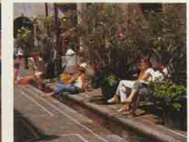
Straßengraben. Gleichzeitig Hochwasserüberlauf. Gestaltete Technik.
