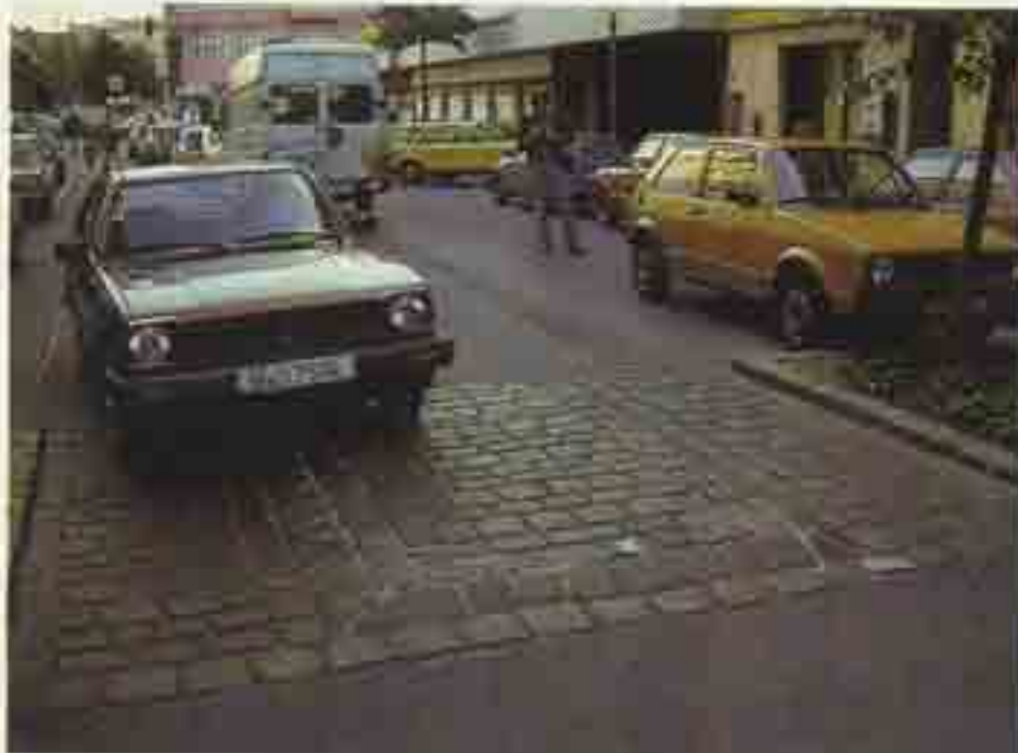
Überfahrbare Inseln verlangsamen und schützen vor dem PKW-Verkehr. Große Lastwagen können sie mitbenutzen. Eine Art Hochwasserzone. Am Rande des Stroms.
